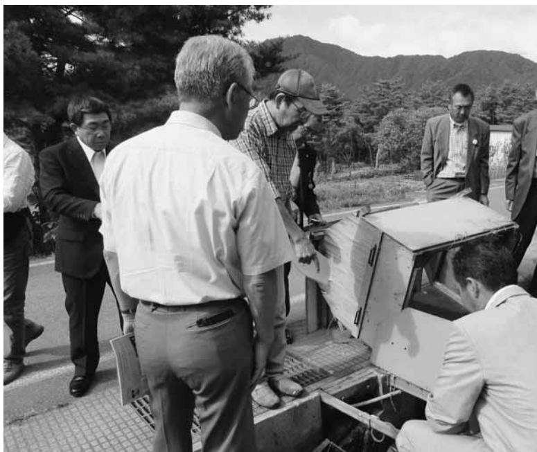
川上式ミニ水力発電所の発電機
