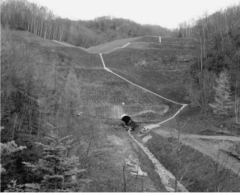
完了した、旧高丘ゴルフ場防災工事
