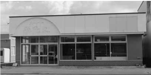
まちなか交流館(仮称)の設置が予定されている空店舗
