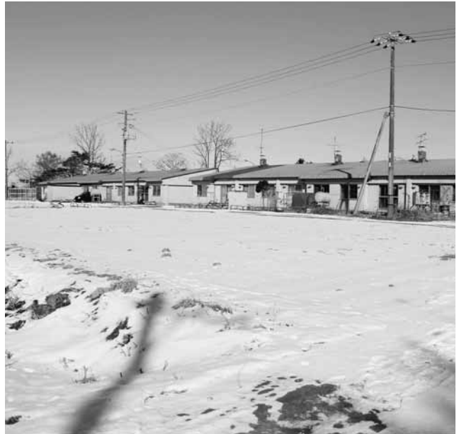
駐車場も整備され、住環境が改善される上厚真C団地
