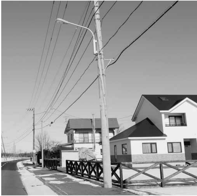
新設された交通安全防犯灯
