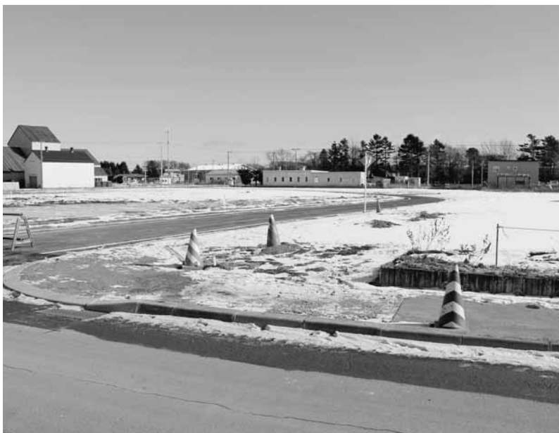
造成が進む上厚真柏区土地区画整理事業
