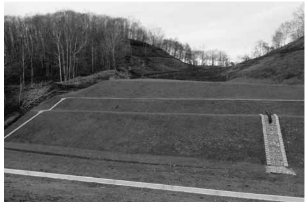
防災工事を終えた高丘ゴルフ場跡地
