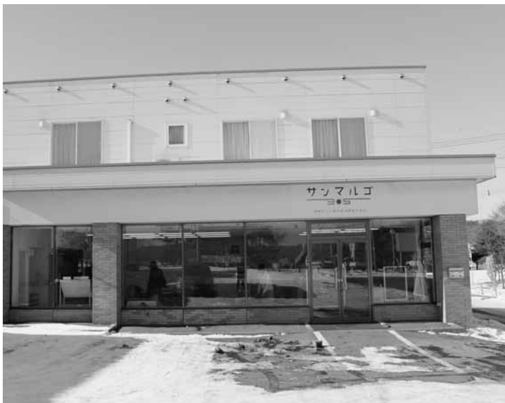
玄関フードをつけることになった、地域おこし協力隊活動拠点(本郷 旧セブンイレブン)
