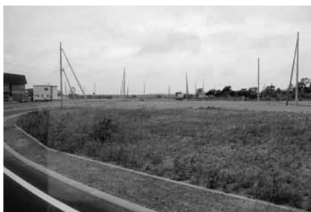
上厚真地区柏土地区画整理事業宅地造成工事（上厚真）
