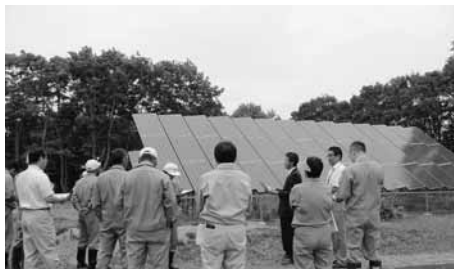
厚南中学校太陽光発電施設工事（富野）
