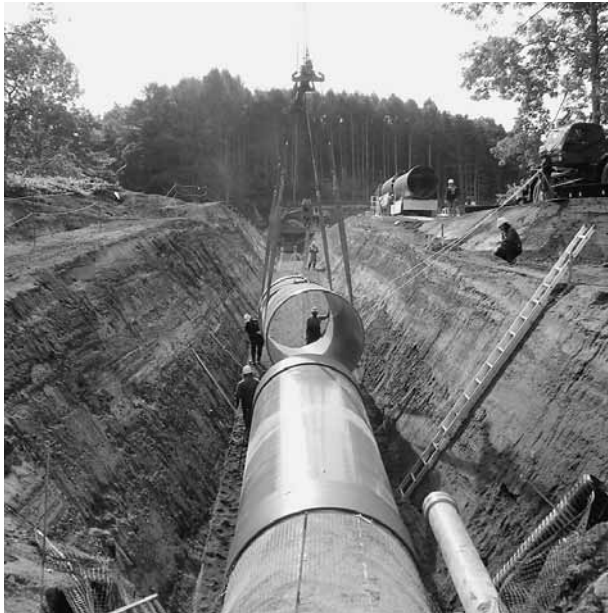
導水管敷設工事
