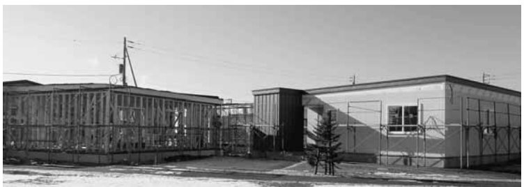
上厚真きらりタウンに建設中の子育て支援住宅
