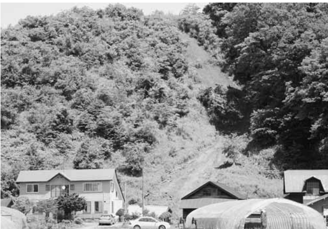
6月17日の大雨で土砂崩れした富里地区
