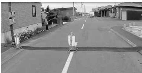
田舎まつり会場道路を横断し設置されている電気・水道設備等
