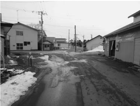
危険度が増している穴田米穀店地先の町道 左から本線が合流
