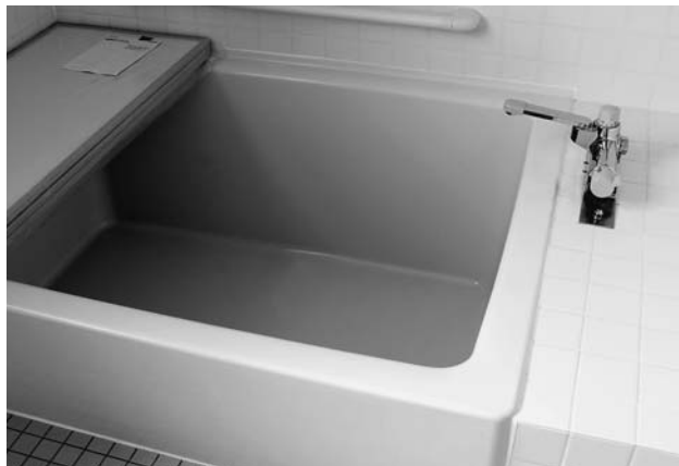
いきいきサポートサロンの浴槽。深くて手すりがない
