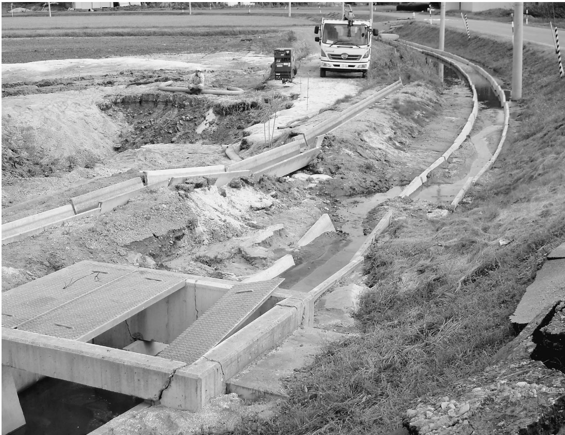
地震により大きな被害を受けた美里地区の導水路・用排水路
