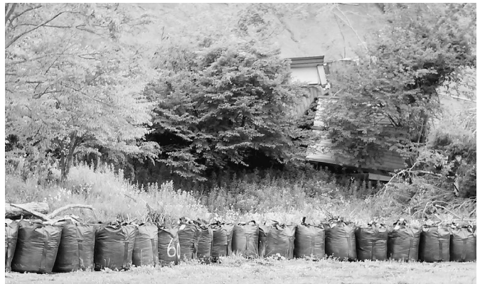
被災した北部地区支援センター
