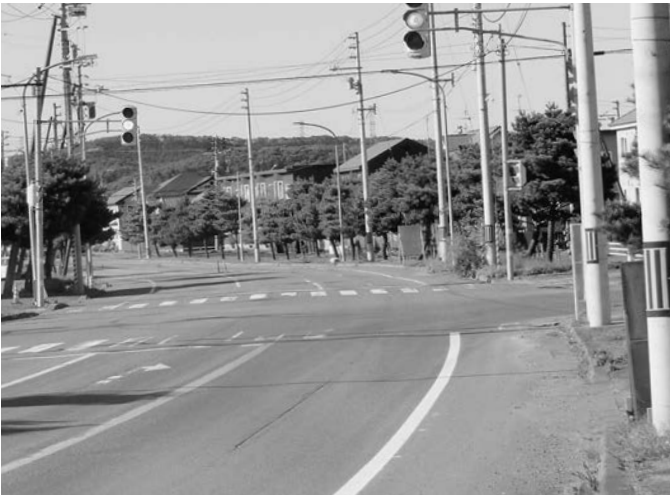
交通規制がない町道表町西通線
