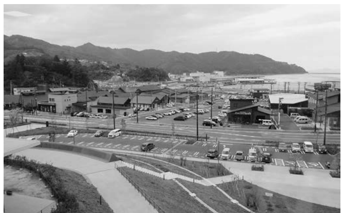
女川町役場庁舎から再開された女川町市街地を望む
