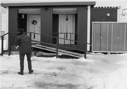
災害共同仮設店舗 京町キューブ
