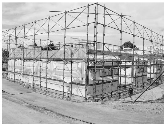
新町地区における建設中の災害公営住宅
