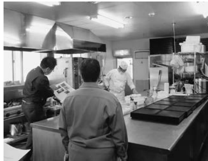
第2厨房の冷暖房機交換
