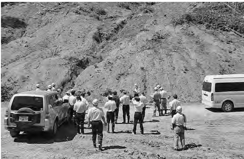
崩壊斜面の植林の実証試験（幌内地区）
