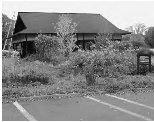
雑草が生い茂っている古民家
