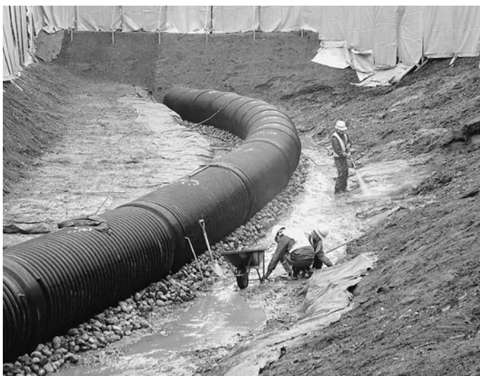
再工事が進められている豊沢地区
