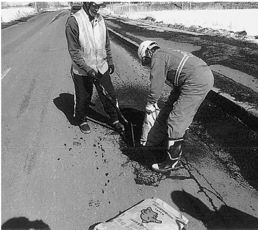
春先の道路補修
