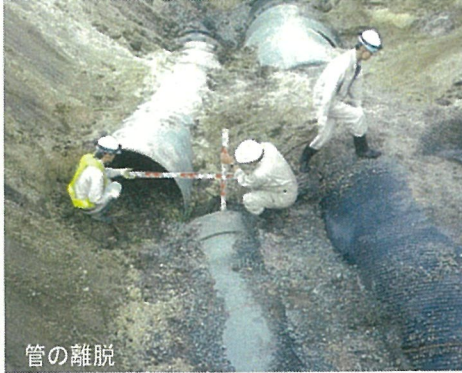
管の離脱箇所からの地下水等の流入
