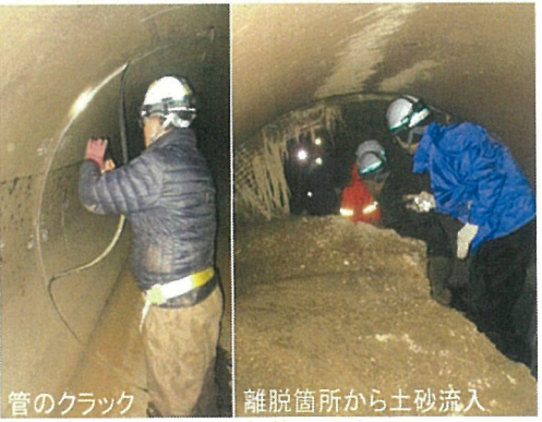
管の離脱箇所からの地下水等の流入
