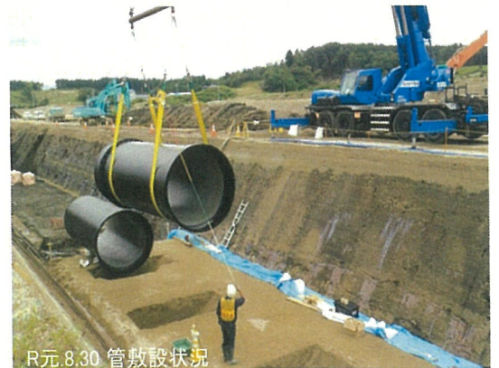
R元.8.30 管敷設状況
