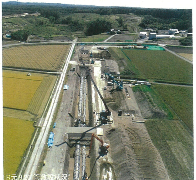
R元.9.20 管敷設状況
