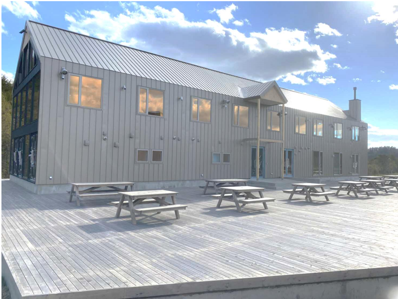
<宿泊施設兼レストラン・直売所併用施設外観写真>
