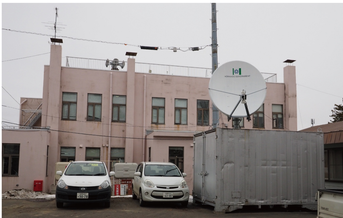
図 12 設計時の南東側立面図と現況の庁舎
