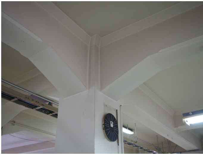
図 11 1 階の柱と梁接合部のディテールと空間的ひろがり
