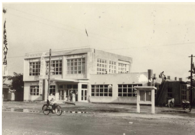
図4 白老町役場庁舎（昭和30年竣工）：白老町役場庁舎建設基本構想 R3.3.26より
