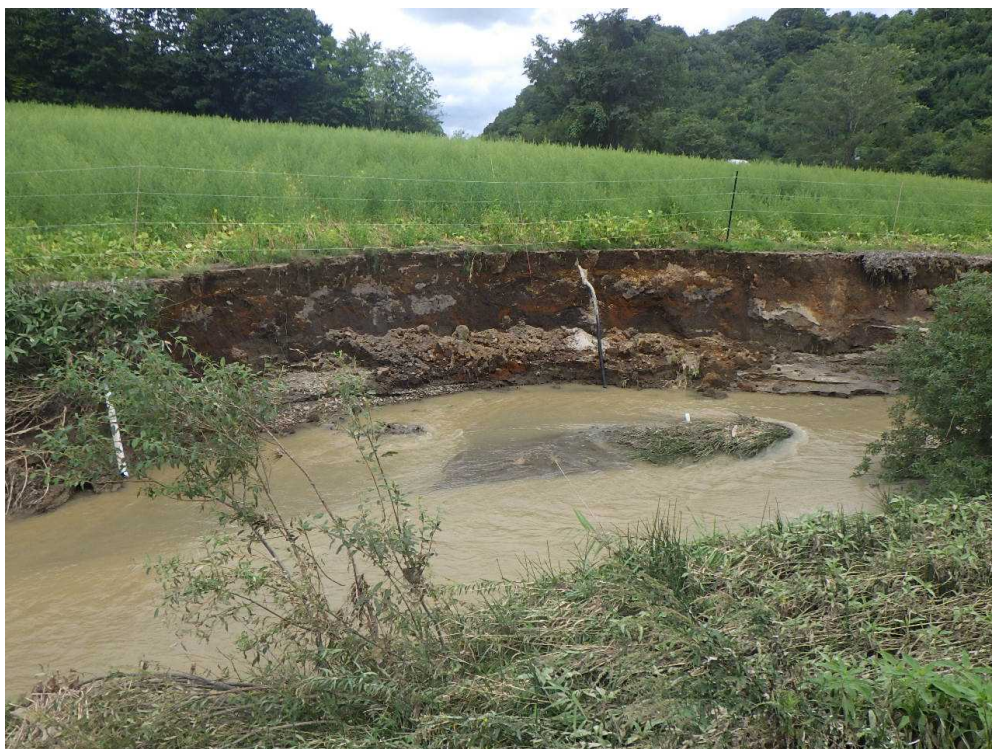
・準用河川ハビウ川③ 河岸欠壊状況
