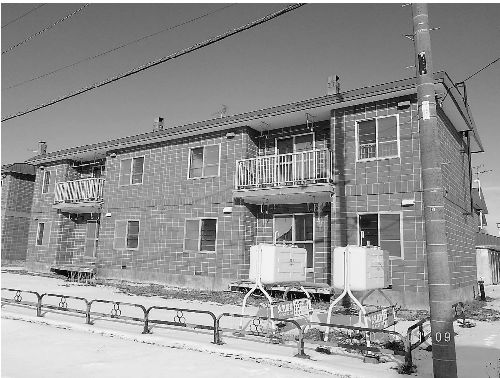
用途廃止をした公営住宅
