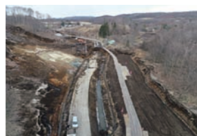
砂利敷の仮道(写真右)と元の道路(写真左)
