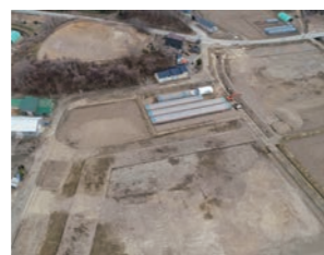
施工中（令和元年12月）
