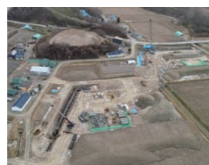
復旧工事完了（令和2年3月）
