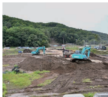
日高幌内川の災害復旧工事
