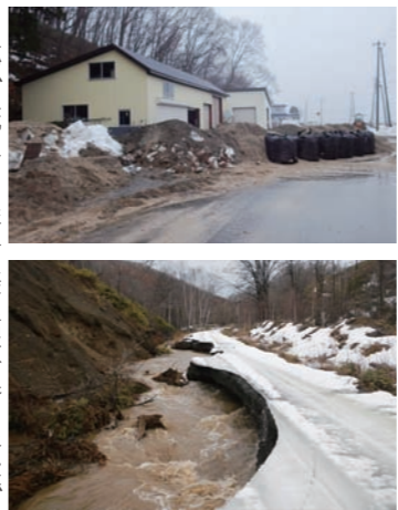
▶土砂が流入した新町美里線(上)と路盤が掘削した幌内宇降線(下)
