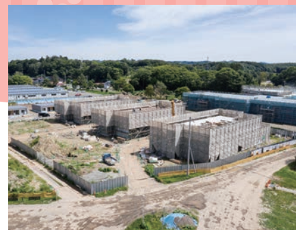
建設中の公営住宅（新町地区）
