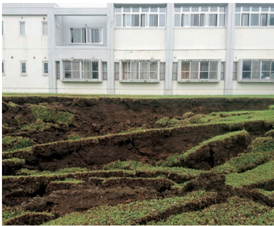
豊厚園／厚真リハビリセンターの敷地内の地割れ 〔北海道厚真福祉会提供〕
