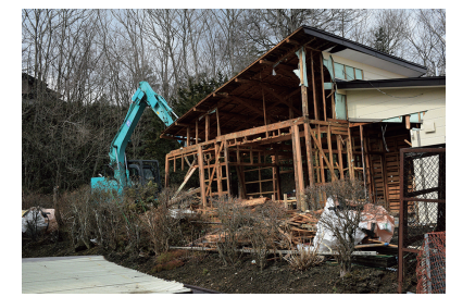
被災家屋の公費解体
