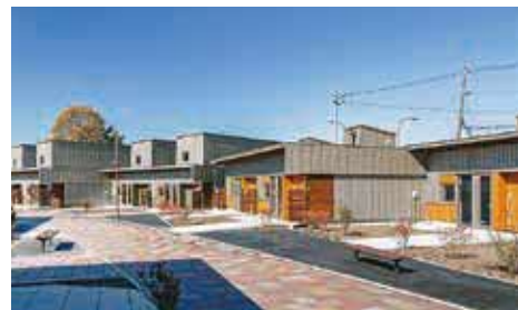
▲災害公営住宅の建設
