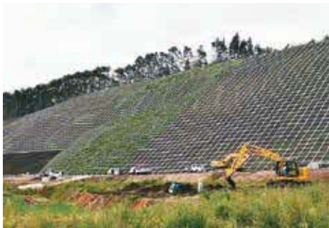
▲災害復旧工事
