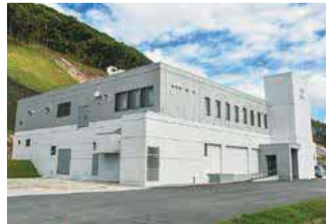
▲富里浄水場の復旧
