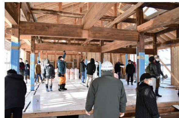
旧山口邸古民家の移築再生現場を見学する参加者たち
