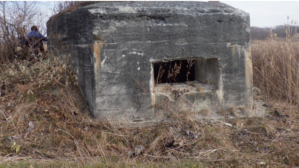
鹿沼地区にあるトーチカ
