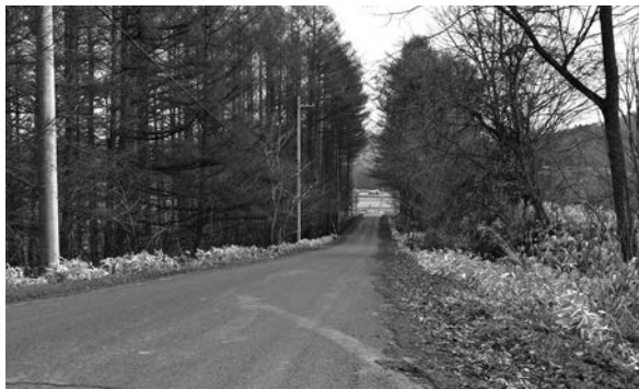
災害時避難路の複線化を図る幌内左岸線
