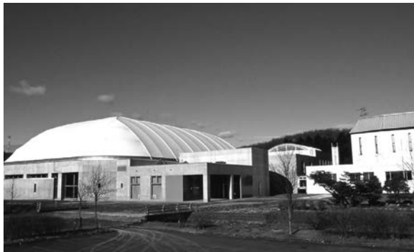
防水工事を行うあつまスタードーム
