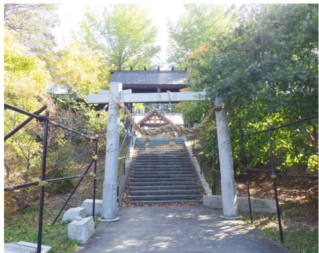
厚真神社の被災状況(2019年10月15日撮影)
