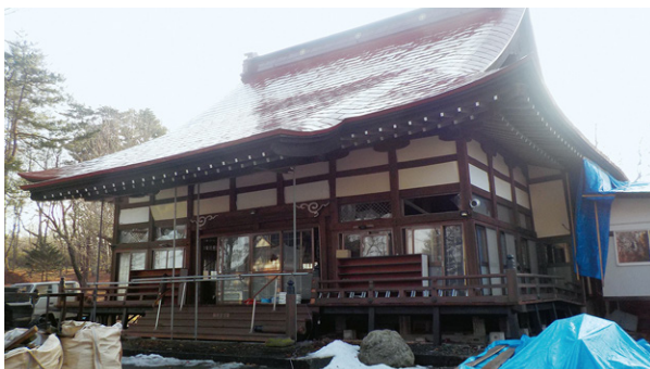
復旧工事前の正楽寺(2018年11月26日撮影)
