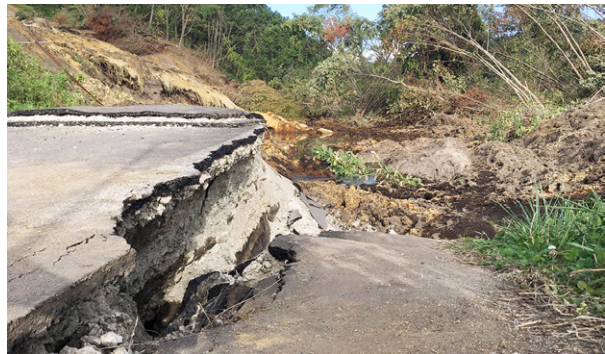
幌里本線（幌里地区）
