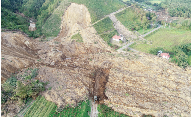
農地を覆う土砂(高丘地区) 平成30年9月12日撮影〔北海道提供〕
