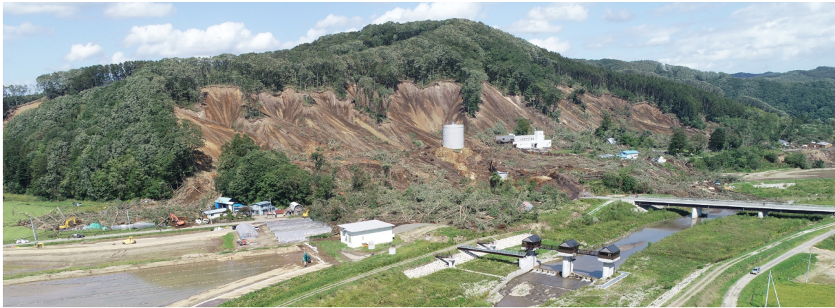
土砂崩れで機能を停止した富里浄水場
