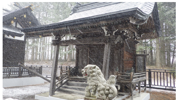
厚真神社の旧本殿も被災した(2020年3月24日撮影)
