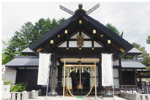
厚真神社 現本殿・常殿・拝殿の現状
