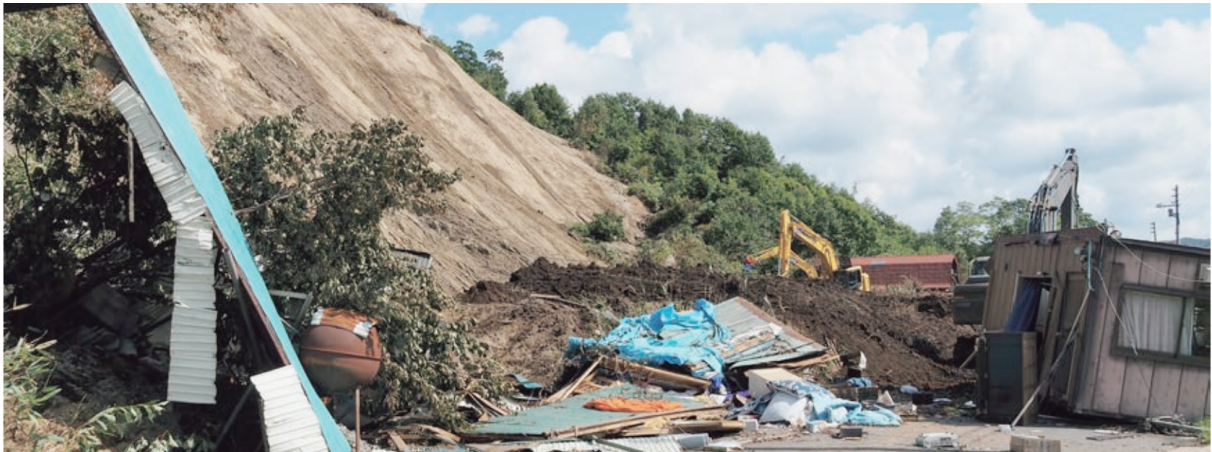
道路啓開（幌内地区）
