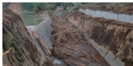
被災直後の厚真ダム (左:洪水吐に流れ込んだ土砂や流木、右:厚真ダムの遠景)
