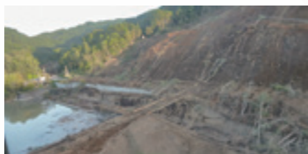
被災直後の厚真ダム (左:洪水吐に流れ込んだ土砂や流木、右:厚真ダムの遠景)
