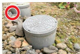
正常な汚水管点検口
