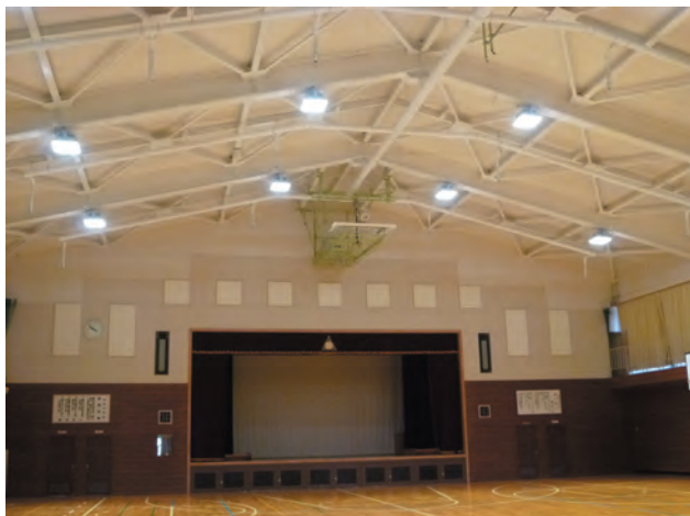
◆防災機能強化した屋体の天井 (厚真中学校)
