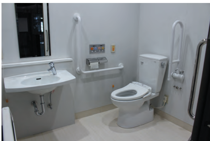
◆多目的トイレ (厚真中学校)
