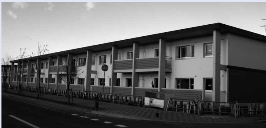
完成間近の表町団地3号棟
