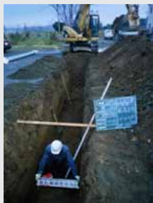
▶新町地区の水道敷設替工事
