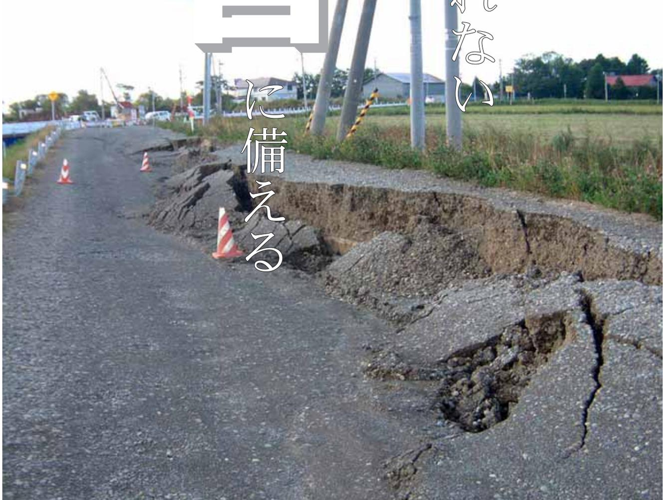
▲平成15年9月26日に発生した十勝沖地震により、路面が陥没した町道豊沢富野線（富野地区）
