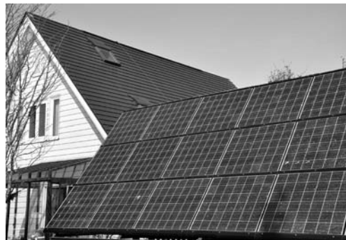
太陽光発電システム
