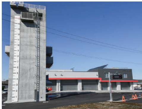
消防訓練副棟(左)と新消防庁舎
