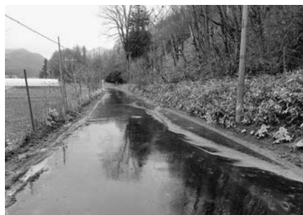
町道（幌内地区）
