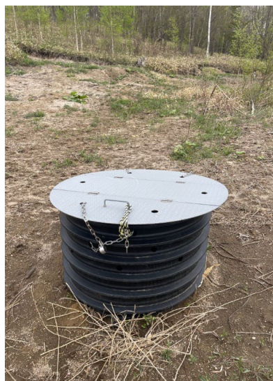
(設置した埋設管)
