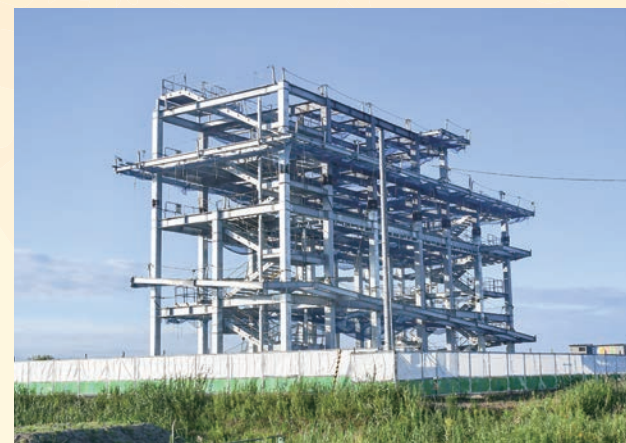
浜厚真に建設中の津波避難施設 上階へのスロープも見える
