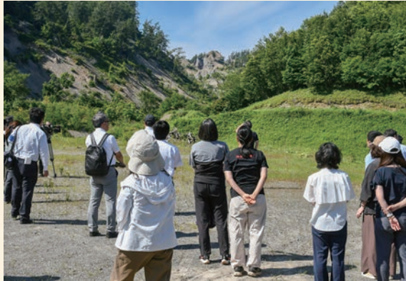
山体が崩落・移動した被災地を見学する教職員の皆さん
