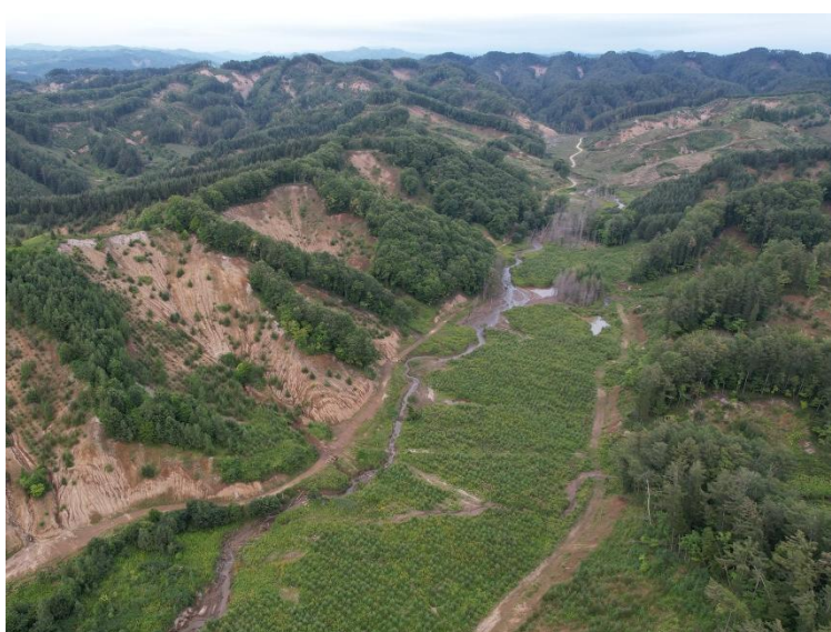
写真2 東和地区の復旧状況
