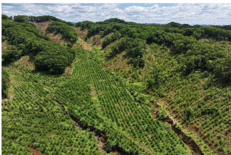
写真1 桜丘地区の復旧状況
